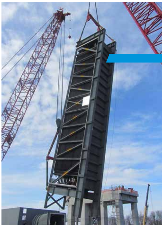
Modulos de una caldera vertical ▶
